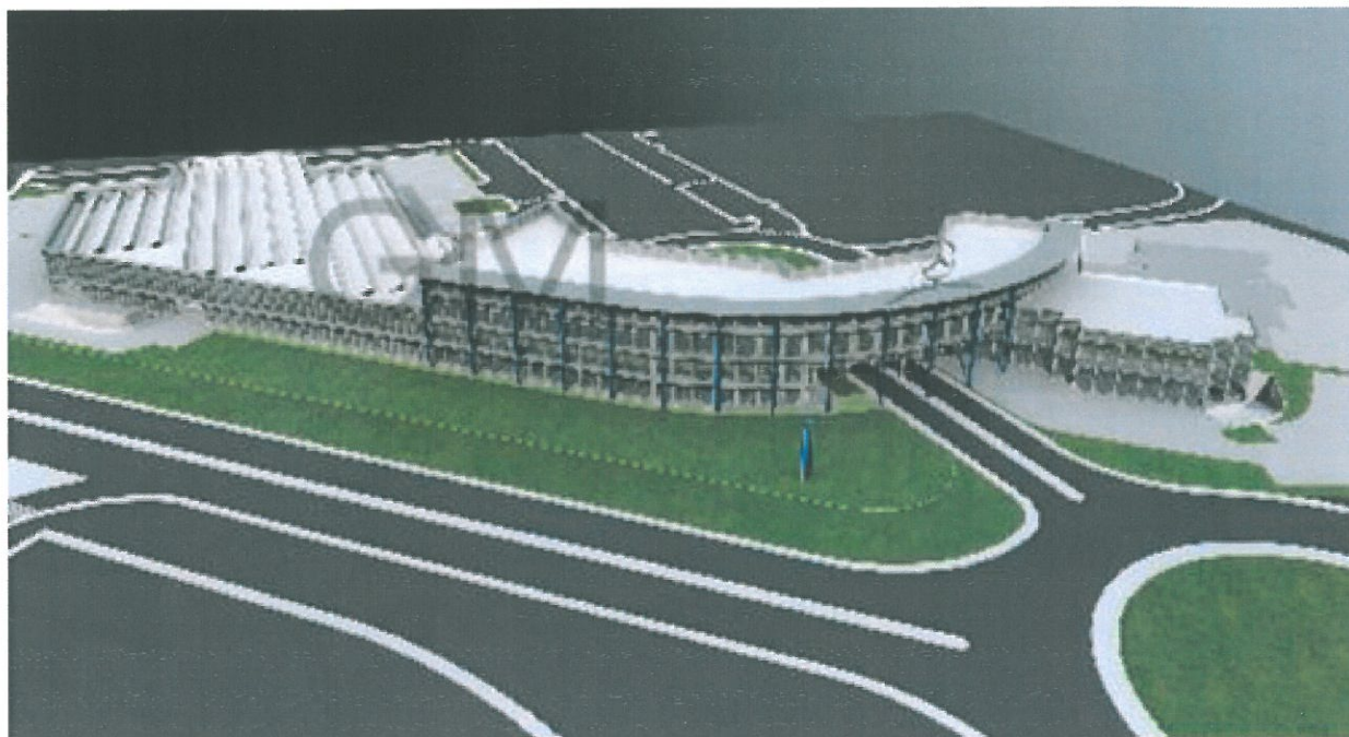
Vista generale del complesso dalla via Zanfi
