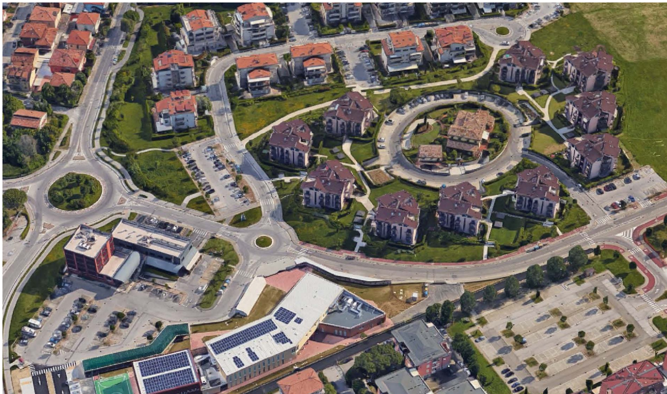
Vista aerea del complesso: il centro commerciale – direzionale e residenziale
