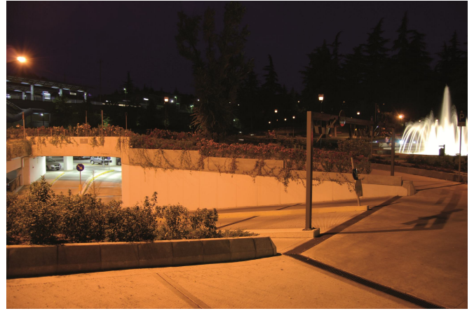
Ingresso ai parcheggi interrati
