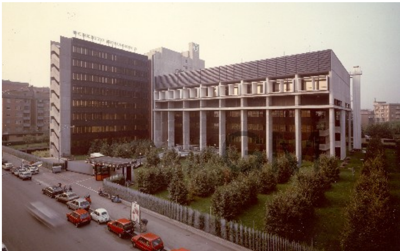
Vista generale da via del lavoro
